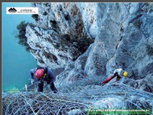
foto 6: Posa in opera di rete in acciaio zincato
