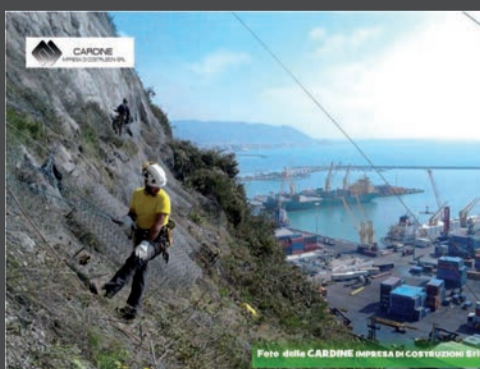
foto 6: Posa in opera di rete in acciaio zincato
