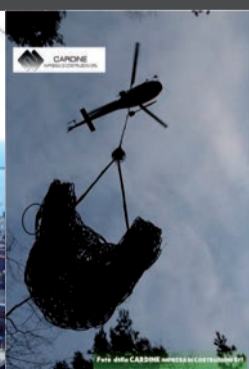
foto 7: Realizzazione barriere paramassi
