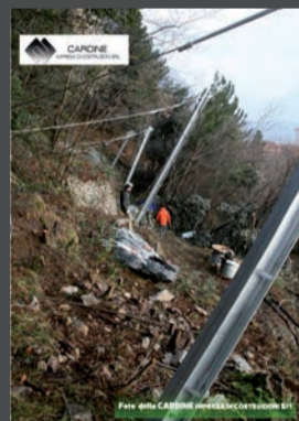
foto 7: Realizzazione barriere paramassi
