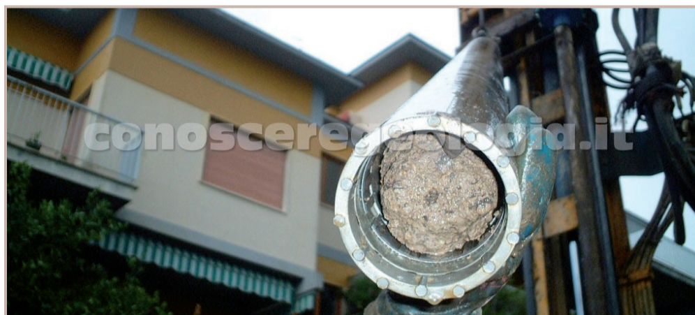
nella foto: Tubo carotiere per sondaggi a carotaggio continuo
